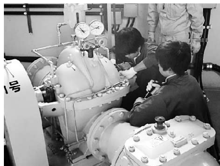
揚水機場の保守点検作業
